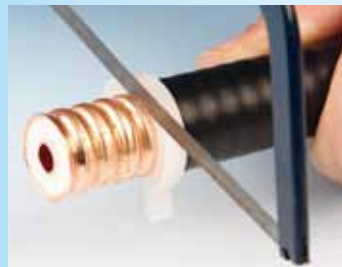
Absetzen mit Sägelehre Trimming with cutting guide
